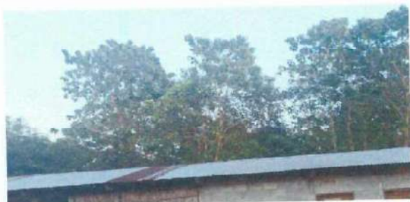
Foto 1: Sustrucción de lámina, por lámina troquelada Calibre 26
