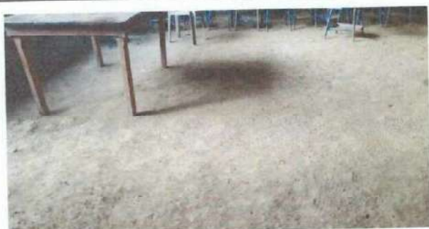
Foto 5: Sustrucción de piso de torta de concreto
