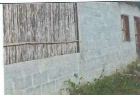
Foto 6: Repello en muros
